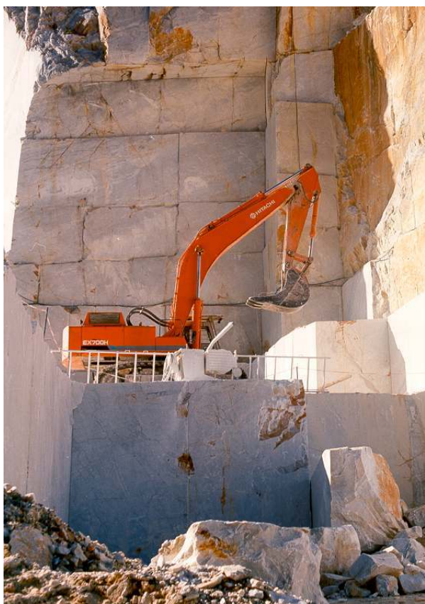
Fig. 8 – Escavatore cingolato da 70 t.
